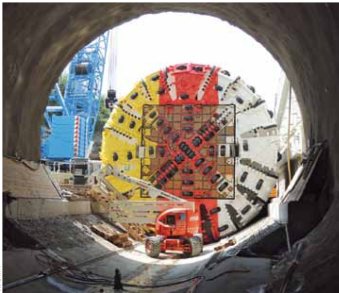
Die Bohrmaschine des Koralmtunnels wurde von ANT mit LWL-Leitungen ausgestattet.
